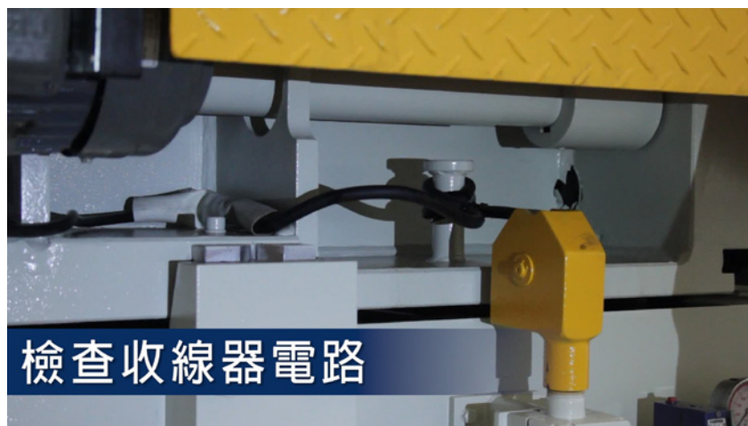
檢查收線器電路
